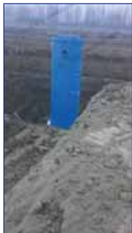
山东菏泽城建工程现场
